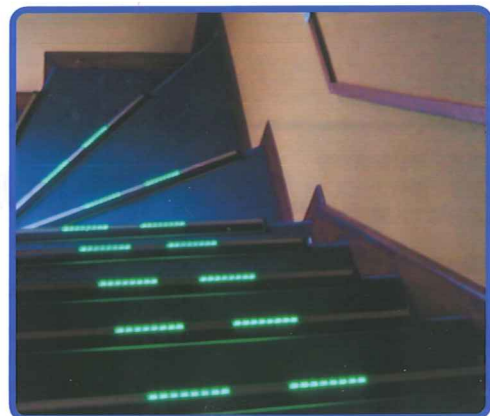
夜間 階段降り口より
